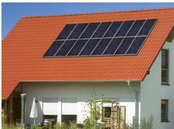
Bild 4: Solarzellen auf Dach.
