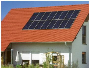
Fig. 4 : Panneaux solaires montés sur toiture.
